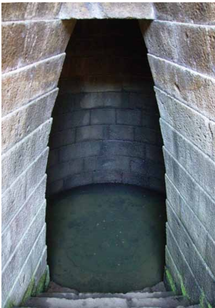
Ill.6. Il fondo della scala d'accesso al piano dell'acqua. Si può osservare sullo spigolo la singolare tecnica costruttiva: ciascuna pietra è arretrata rispetto alle sottostanti. (Foto G. Lebeuf)
